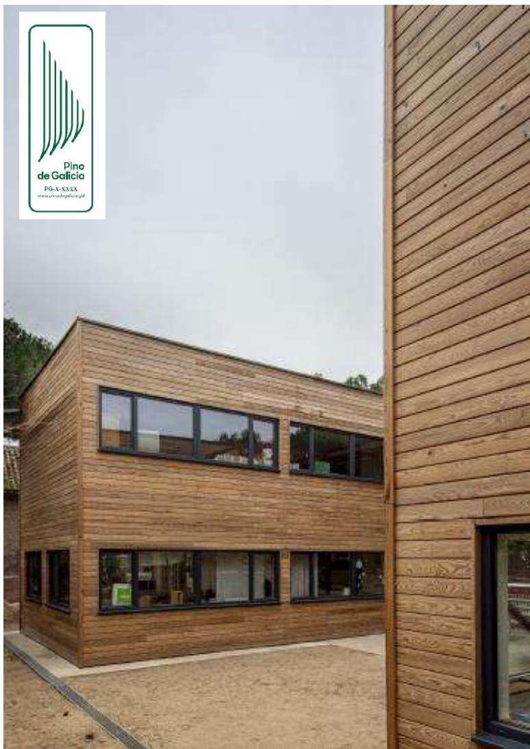
Fachadas en madera termotratada de Pinus pinaster de Galicia.
