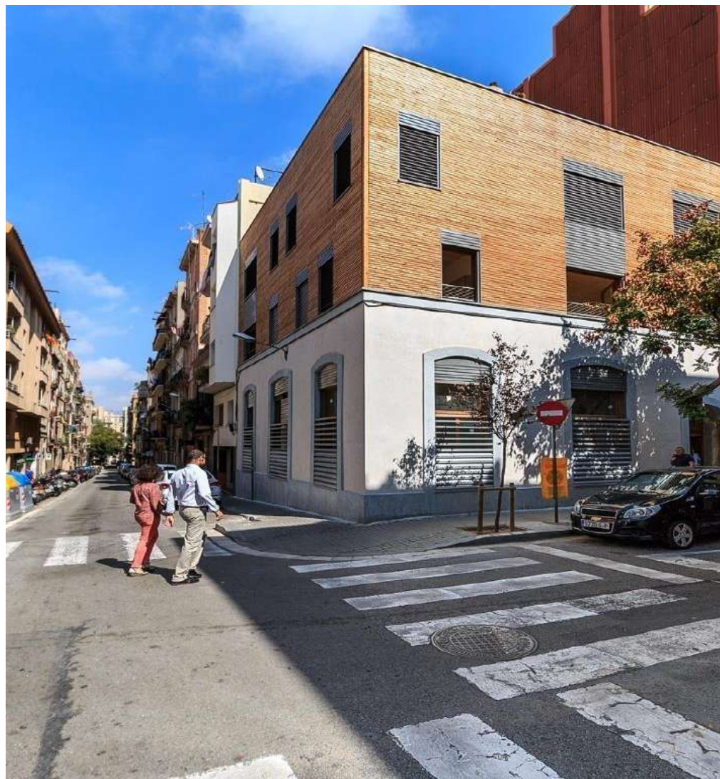
Fachadas en madera termotratada de Pinus pinaster de Galicia.
